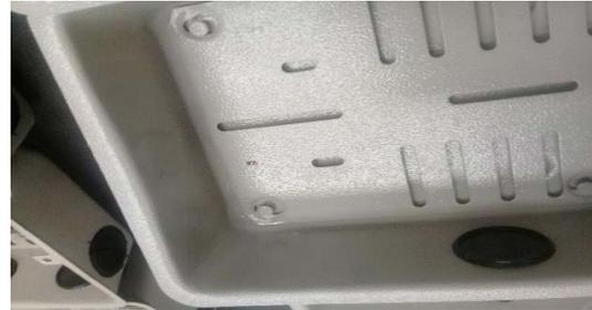
Figura 6: Fallas de pintura en la base de una caja metálica
