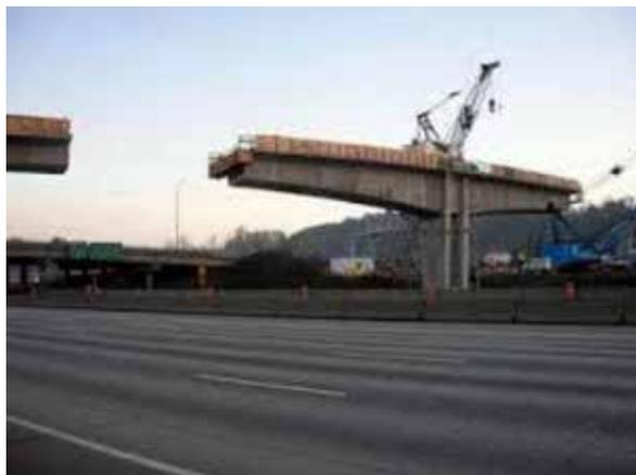
**d) Articulación (bisagra):** Permite unir, conectar dos secciones de viga.
